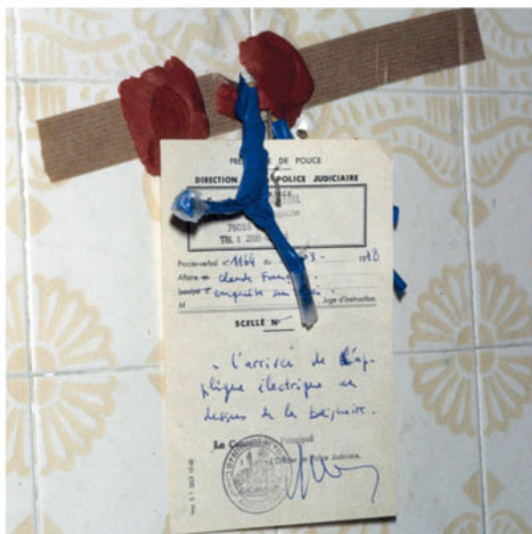
Emplacement de l'applique où s'est électrocuté Claude François, dans sa salle de bain. Photo prise quelques heures après l'accident.
